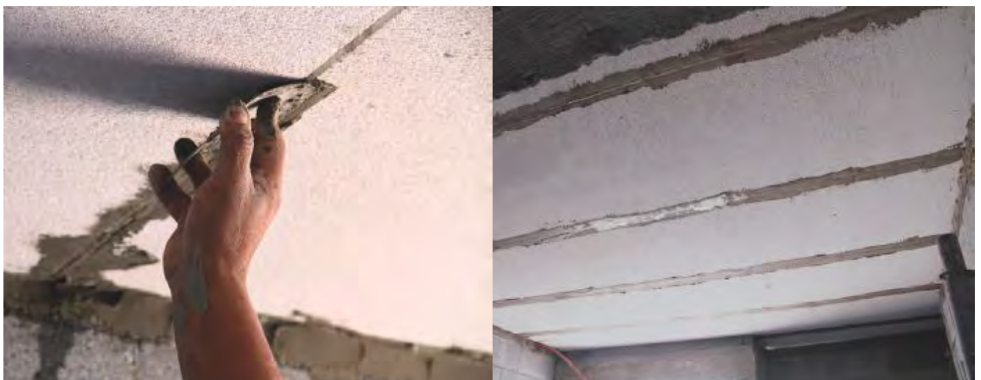
Fig. 12: Sellado de junta entre paneles por la parte inferior.
